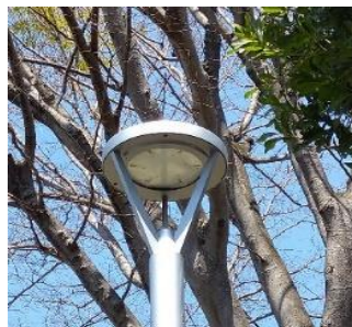
西館廻り 屋外灯取替修繕 (LED照明に取替え)
