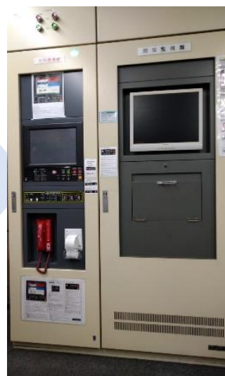
自動火災報知設備 更新第3期修繕 (警備員室内の総合盤)
