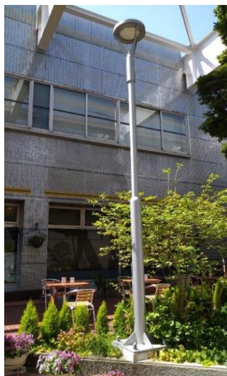
西館廻り 屋外灯取替修繕 (LED照明に取替え)
